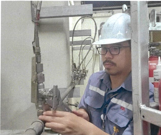
Local Operator ตรวจสอบพบว่ามี Hydrogen Gas รั่ว บริเวณ stem valve 22QJF20AA001 สาเหตุจาก locking nut คลายตัว จึงนำประแจเลื่อนมาถอดนอตเพื่อแก้ไข
