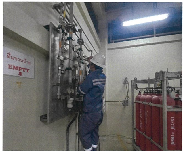
Local Operator ประเมินความเสี่ยงและ Isolate valve Hydrogen Gas Supply Skid
