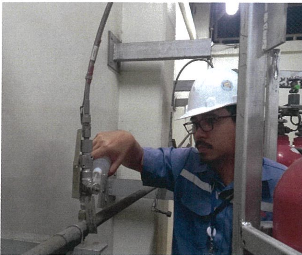
Local Operator ใช้น้ำยา Snoop ตรวจสอบจุดรั่วบริเวณก้าน Valve และทำการแจ้ง หดพน2/4-ฟ.
